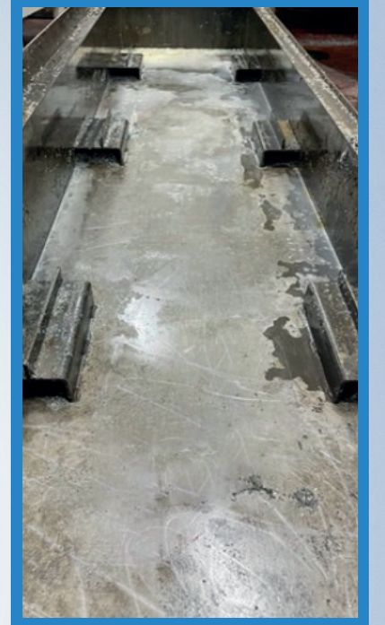
Tank Temizliđi Sonrası
